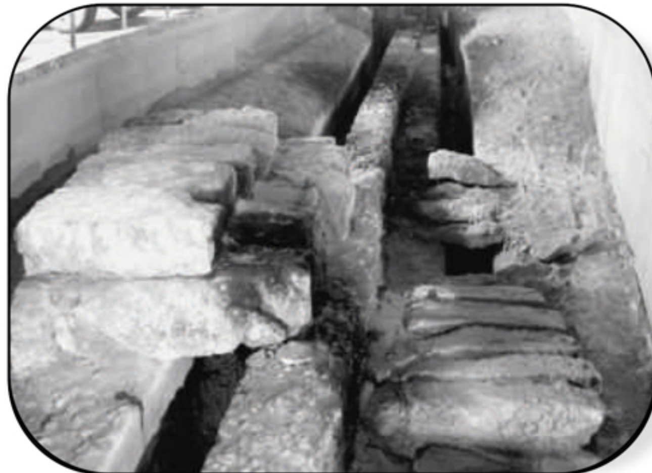
Fig. 21 Restos de canalizaciones. Acueducto romano (izquierda) y Qanat islámico (derecha)
